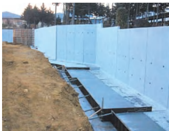
施工状況（底板部現場打ち）
