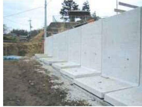
敷き段差施工
