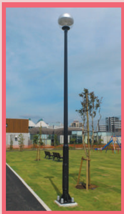
照明灯基礎ブロック
