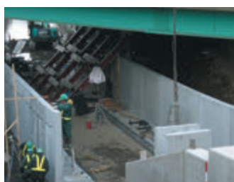
高架下でのL型水路ブロック搬送（横引）据付施工
