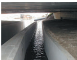
高架下での大型フリーウム搬送（横引）据付施工
