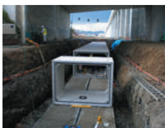
高架下でのボックスカルバート搬送（横引）据付施工
