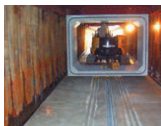
覆工版下でのボックスカルバート搬送（横引）据付施工
