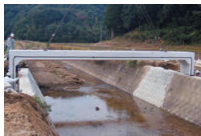
改修後新設橋
