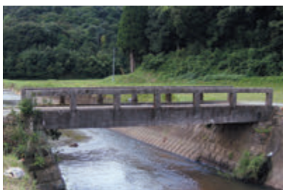
改修前既設橋
